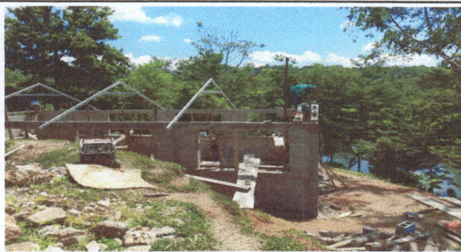
Foto1. Instalación de estructura de techo
