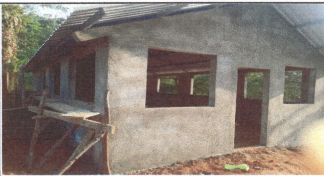
Foto 5: Reparación de puertas y ventanas de la escuela
