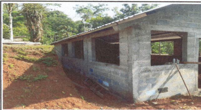
Foto 2: Intalación de techo de la escuela
