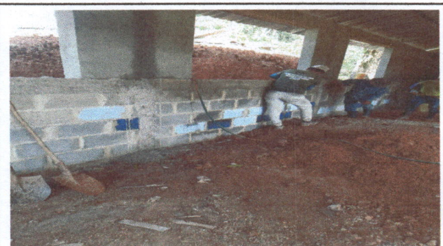
Foto 3: Reparación de paredes de la escuela
