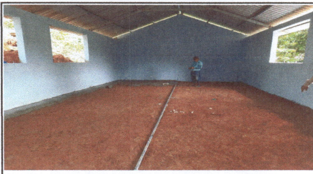
Foto 4: Reparación de piso de la escuela.
